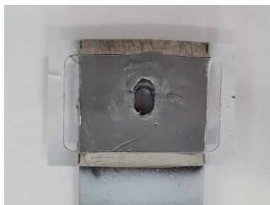
图 13 液体垫片损伤情况
