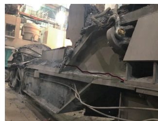
图 1 现场车体西侧开裂处
