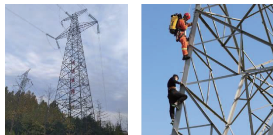
图 1 高压输电铁塔 图 2 工人攀爬高压输电铁塔
