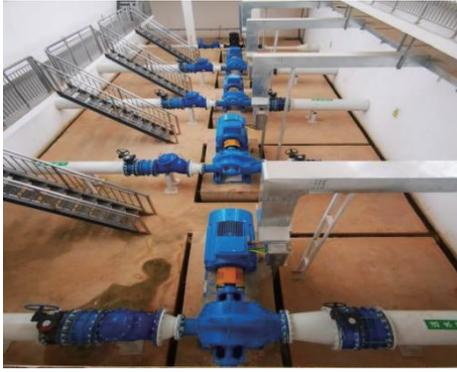
图1 送水泵站现场机组
